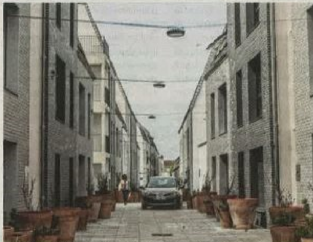
La travée centrale est l'un des éléments phares du projet immobilier érigé sur le site de l'ancienne polyclinique du Tondu. THERRY DAVID / « SUD OUEST »
